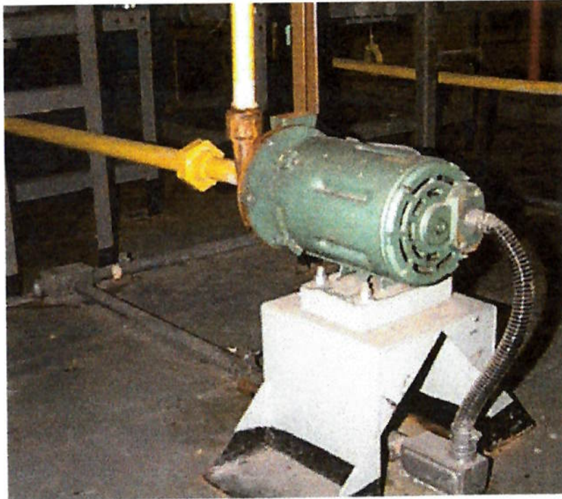
Figura 36: Bomba centrífuga
