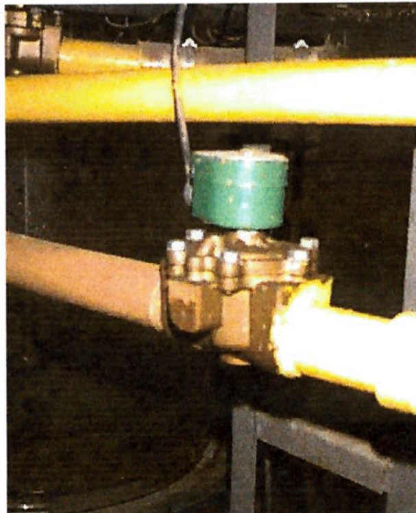
Figura 34: Válvula solenóide
